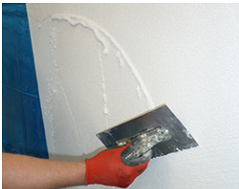
Nakładanie: nakładać pacą stalową na grubość kruszywa
