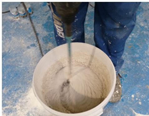
Mieszanie: tynk wymieszać z wodą 4,25-4,75 litra na 25 kg Planitop Mineral
